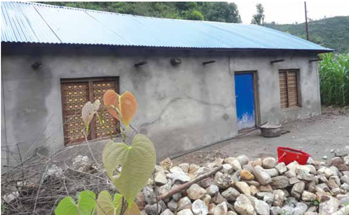
गाउँघर क्लिनिक भवन, त्रिवेणी गाउँपालिका वडा नं. २
